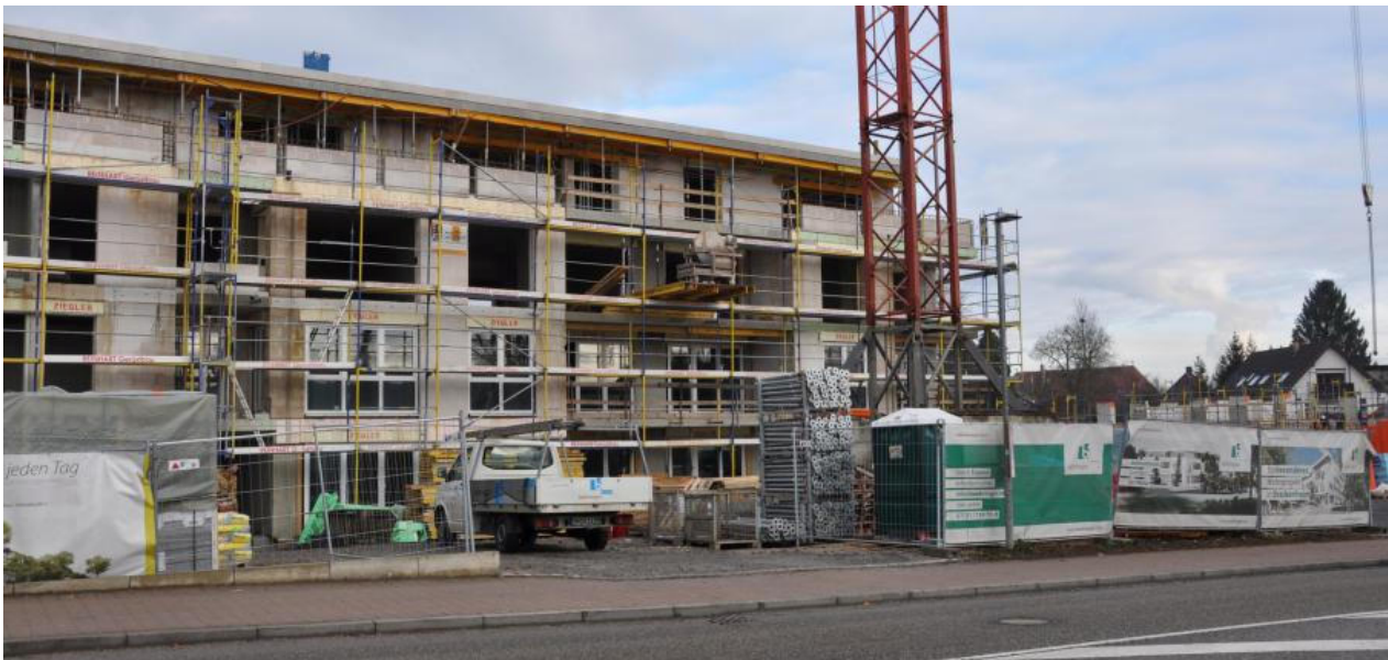
Auf dem ehemaligen Bleyle-Areal baut ein Investor das Projekt "Schlosswiesen West" mit Mehrfamilienhaus, Kita und Räumen fürs Amtsgericht.
