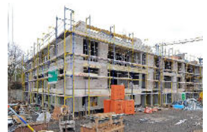
Das Bauprojekt auf dem ehemaligen Areal macht gute Fortschritte: In diesem Gebäudeteil wird im Erdgeschoss und Obergeschoss der Kindergarten untergebracht. In den beiden weiteren Geschossen sind Wohnungen geplant.
