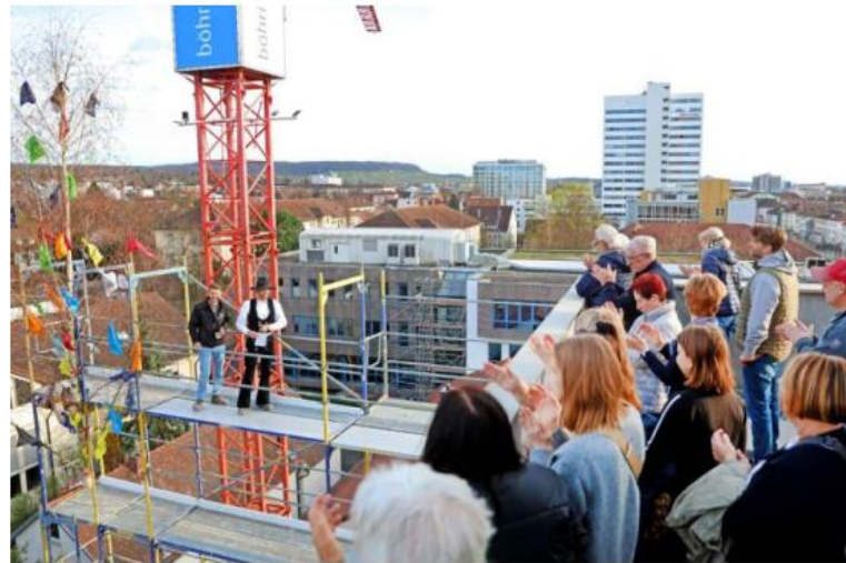
Bauleiter Silas Beck und Zimmermann Thorsten Weimar (links) beim Richtfest am Stadthaus Otthello. Bis zum Herbst entstehen hier 45 Wohnungen. Foto: Ralf Seidel
